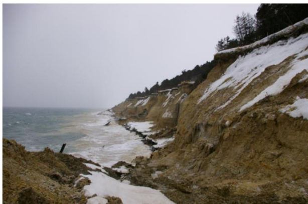
(崩落地：施工前)
