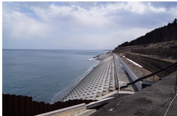
(崩落地：施工後)
