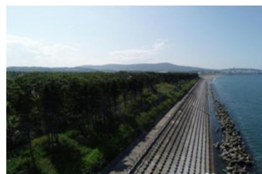
(傾斜護岸工の施工箇所)
