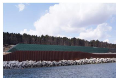
(山腹工及び鋼矢板護岸工の施工箇所)
