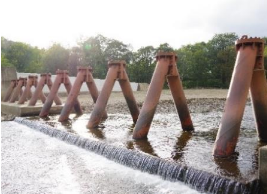
スリットダム（幌加内町字朱鞠内）
