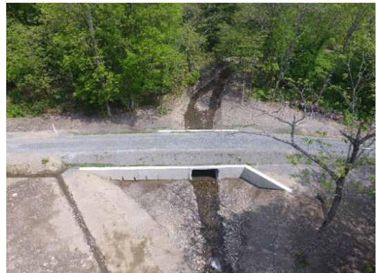
林道災害復旧工事（幌加内町政和）
