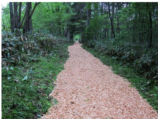
木材チップが敷設された歩道
