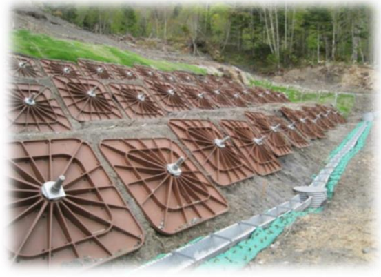
地すべり地の復旧(占冠)
