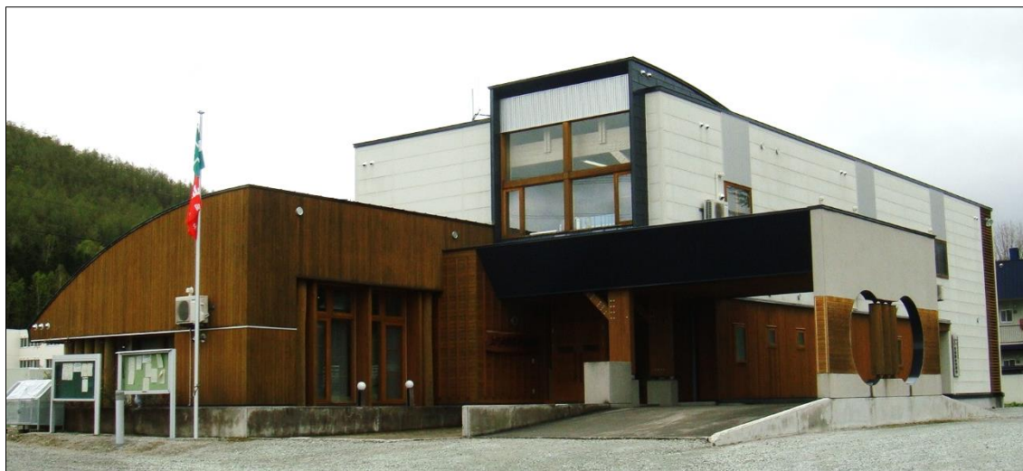
上川南部森林管理署庁舎 南富良野町所在(平成14年落成)
