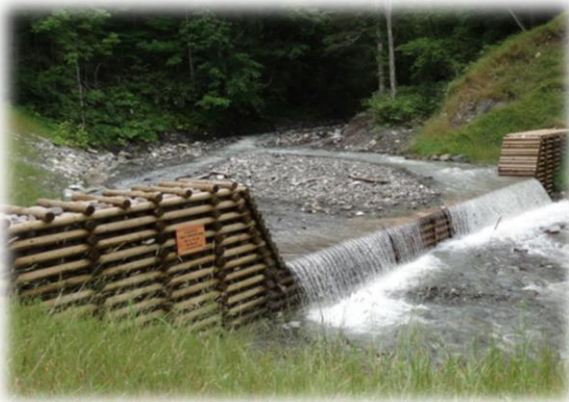
景観に配慮した治山ダム(富良野)
