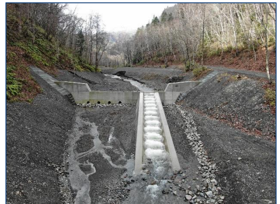
既設の治山ダムに魚道を設置
