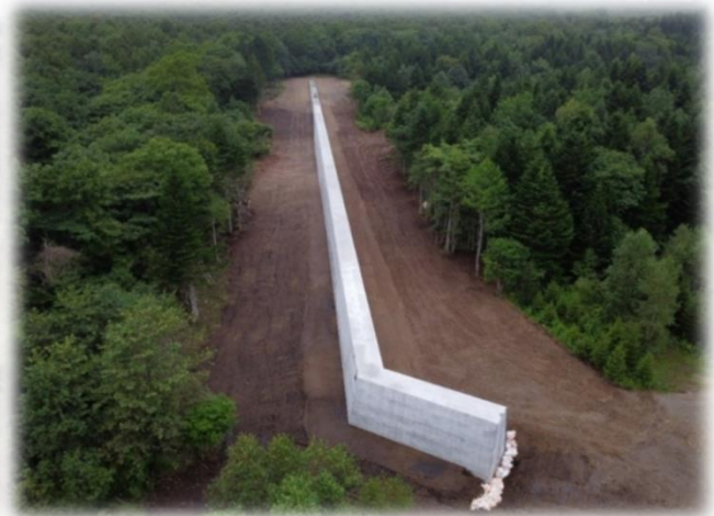
令和5年度完成 導流堤右岸部（西側）
