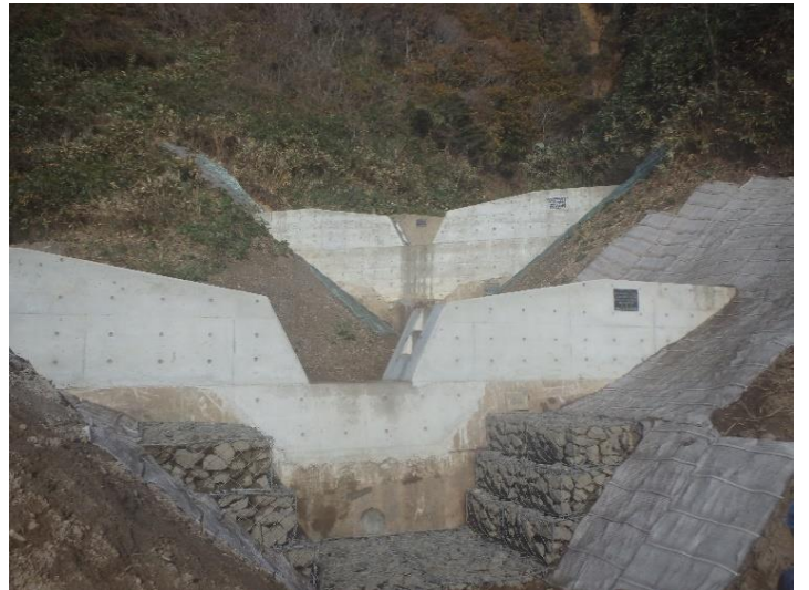
【奥尻町：稲穂他2地区災害関連緊急工事】 (写真：稲穂地区嵩上げ：2基)
