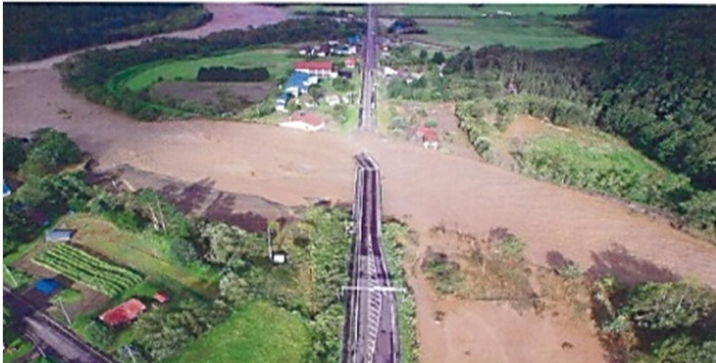
国道274号「千呂露橋」の被災状況（平成28年）
