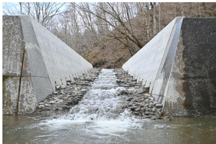
魚道を設置したアベツ国有林の治山ダム
