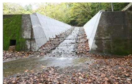
アベツ川の治山ダムに設置した魚道
