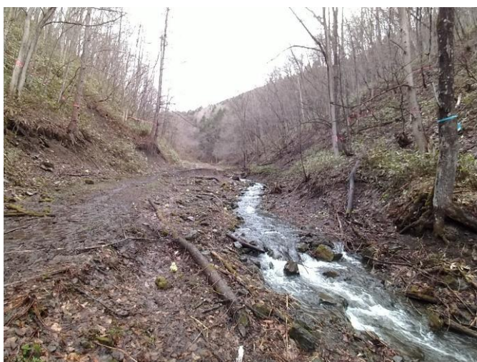
施工前の現地(遠軽町)(令和5年4月)
