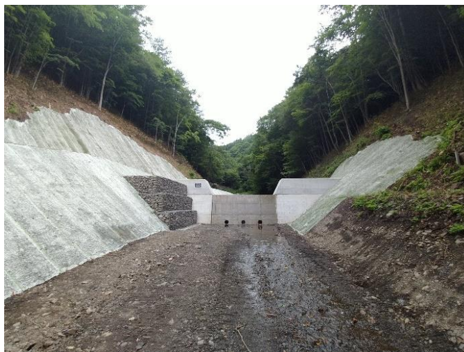
施工後の床固工(遠軽町)(令和5年8月)
