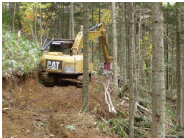
バックホウによる森林作業道の作設
