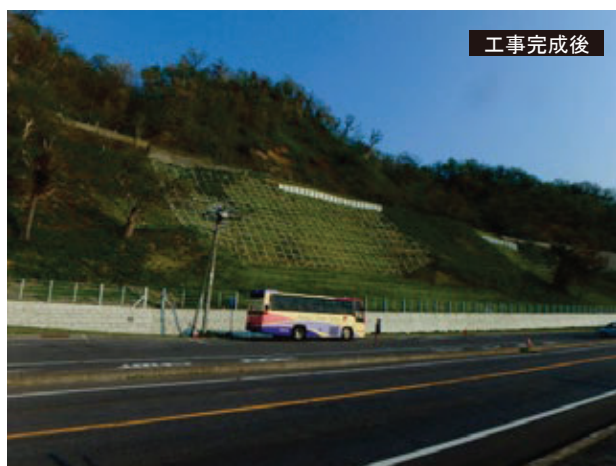
治山工事により復旧した法面
