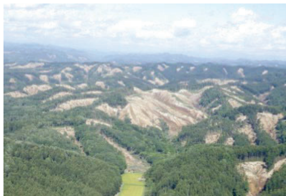
上空から確認した被害状況（北海道胆振東部地震（厚真町））
