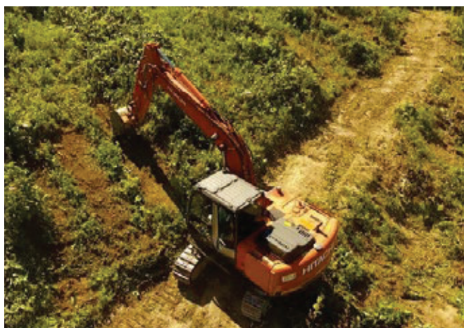
大型機械による地拵え
