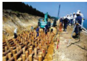
●木柱を用いた土木工事
