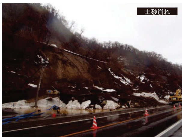
道路まで崩れ出た土砂
