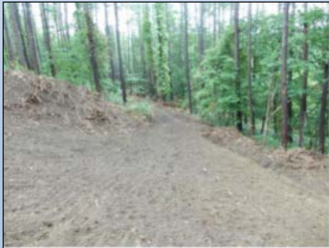
地表処理作業直後
