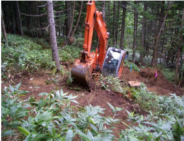
図5 地がき個所の施工風景
