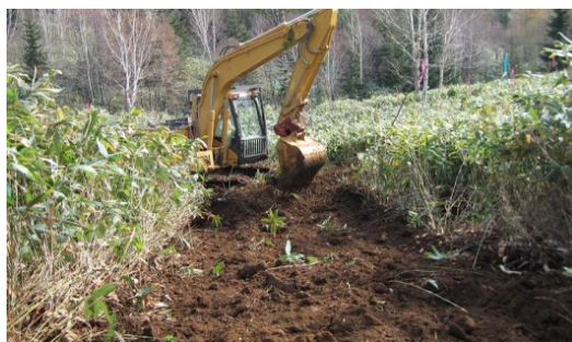
(写真)バックホウによる地拵
