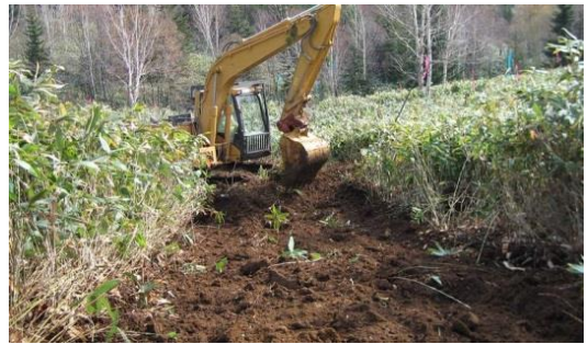
(写真)バックホウによる地拵
