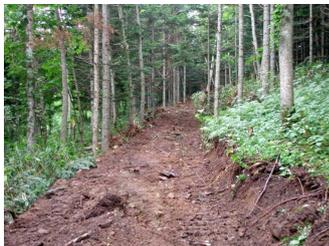
図一3 切土量を極力少なくなるように作設
