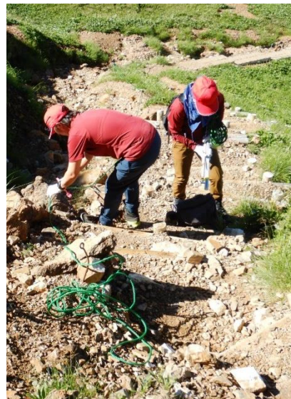
グリーンロープの設置
