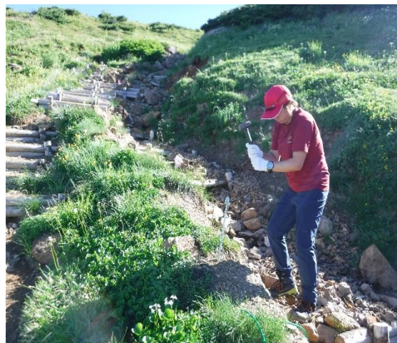
グリーンロープ用の杭打ち
