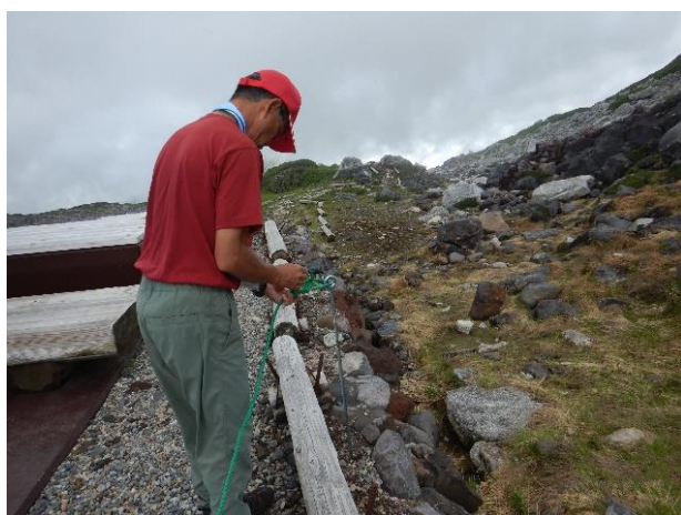
グリーンロープの設置
