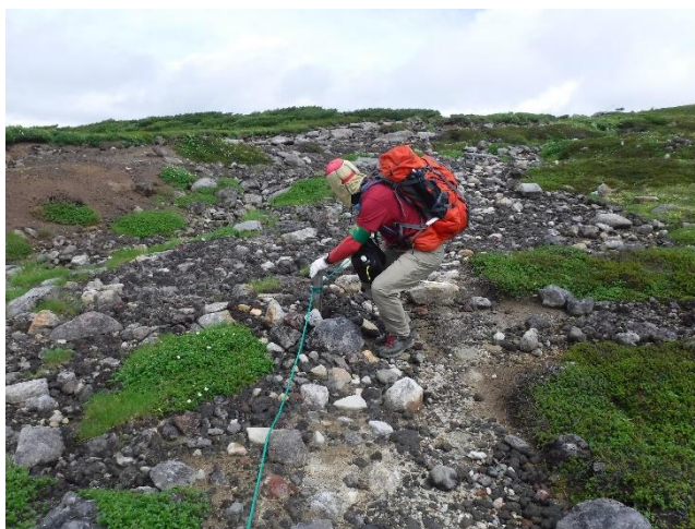
グリーンロープの設置
