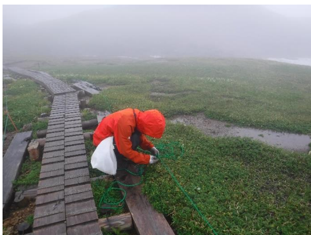
グリーンロープの設置
