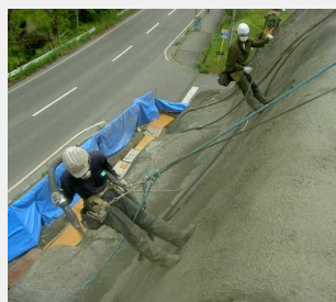
②接着モルタル吹付工
