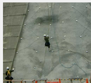
④金網・ロープ設置工
