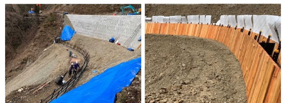
写真3 現場での作業状況(作業全体の52.6%)
