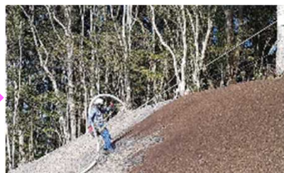
写真4：吹付作業 (21年12月撮影)
