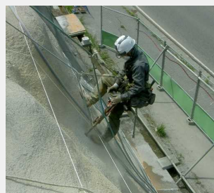
③補強鉄筋工
