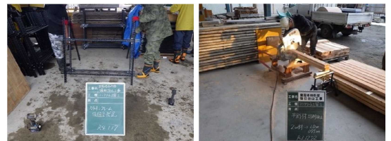
写真2 会社資材置場での作業状況(作業全体の47.4%)
