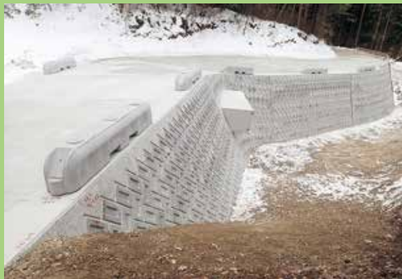
白ヶ久保林道災害復旧工事 施工者 付知土建株式会社
