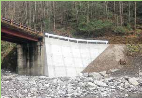
藪原林道災害復旧工事 施工者 木曾土建工業株式会社
