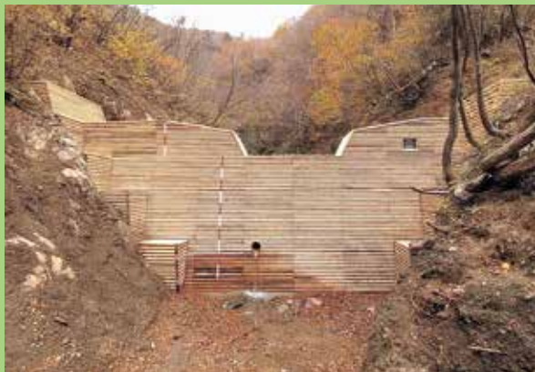
川上（池ノ又谷2）復旧治山工事 施工者 西濃建設株式会社
