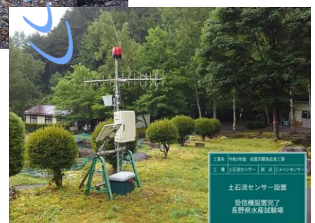
土石流センサーの設置 (日義国有林)
