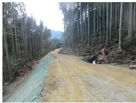
国有林を通過する林道を作設することで、民有林での施業が可能となったケース(岐阜署)
