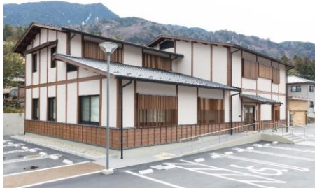
庁舎の新築(南木曾支署)
