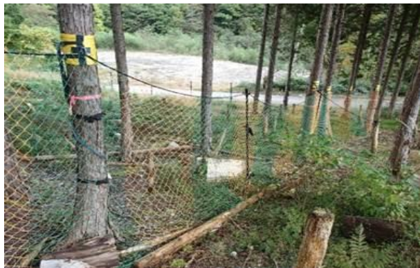
立木を支柱として利用した低コストな防護柵 (東濃署)
