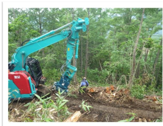
スイングヤータによる集材作業
