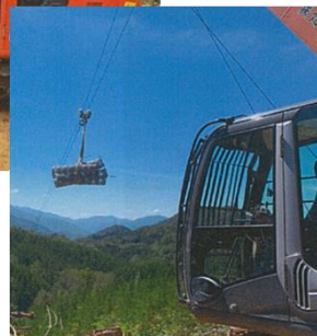
スイングヤーダによる防護柵資材運搬
