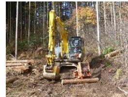
オイルクイックによるバケット交換
