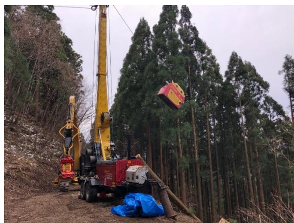
(牽引式タワーヤードによる集材作業)
