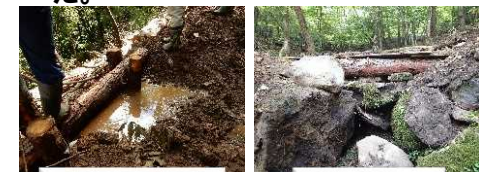
沈砂を兼ねた丸太組
