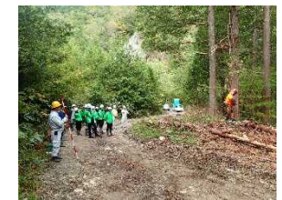
大学生現場視察(伐倒の様子)
