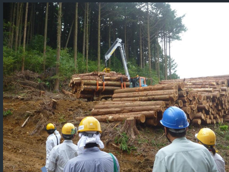
土場の工夫について確認
