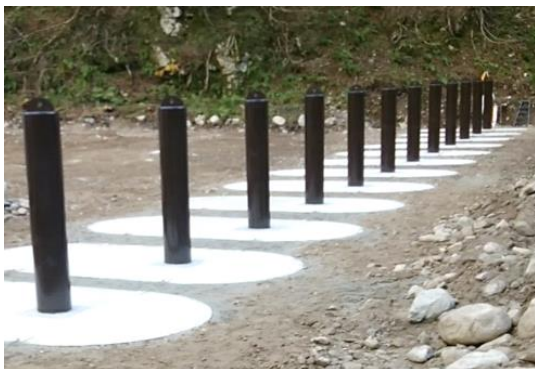
流木捕捉工（完成時）
