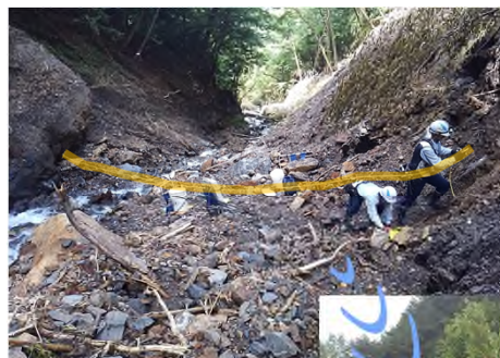
土石流センサーの設置 (日義国有林)
