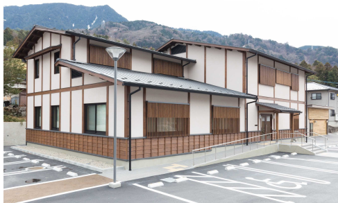
庁舎の新築(南木曾支署)
