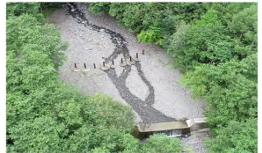
流木対策の実施(流木捕捉工)(中信署)
