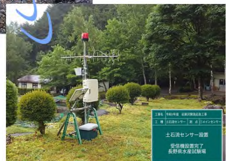
土石流センサーの設置 (日義国有林)
