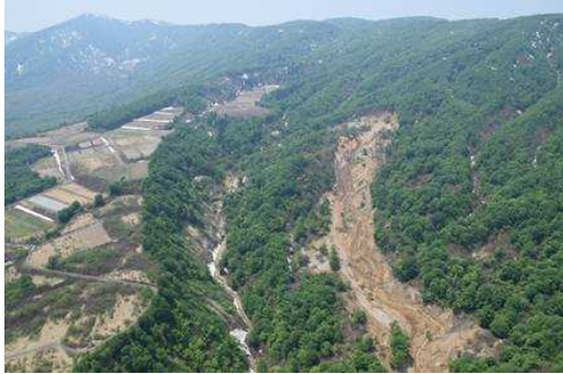
山腹崩壊(源頭部)の状況
