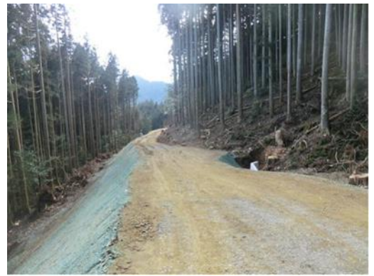
国有林を通過する林道を作設することで、民有林での施業が可能となったケース (七宗国有林)
