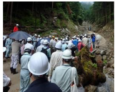
地元住民等への復旧工事現場での説明
