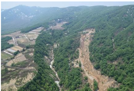
山腹崩壊(源頭部)の状況
