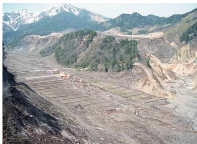
被災3年後 床固工・水路工により溪床が安定
