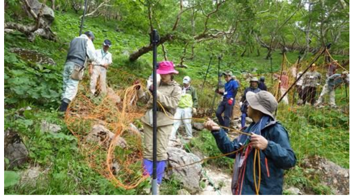
ボランティアの協力による防護柵の設置 (南アルプス仙丈ヶ岳2,600m付近)
