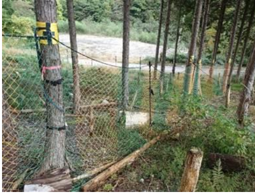
立木を支柱として利用した低コストな防護柵 (東濃署)
