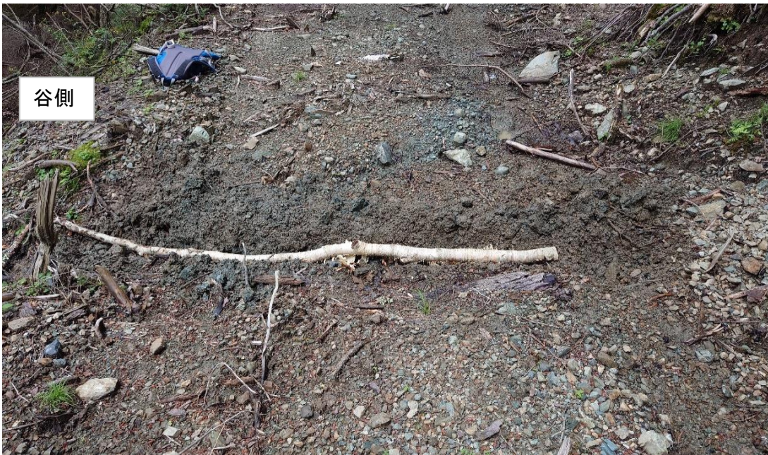
排水導線として現地に落ちていた枝条を利用
