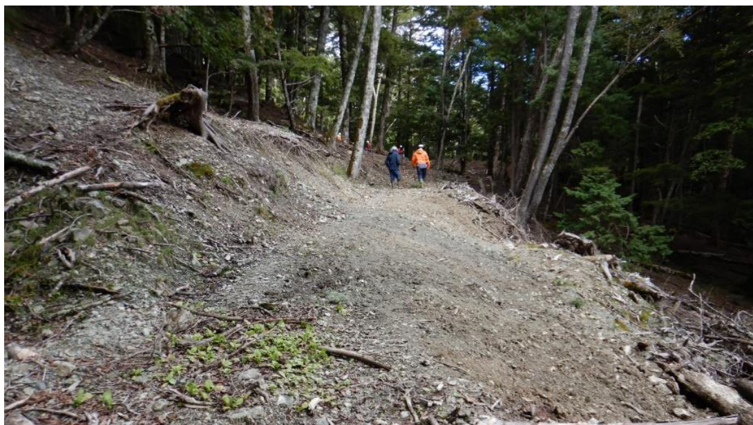
施工後 上の写真 の反対側 から撮影
