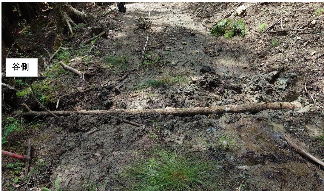
排水導線として現地に落ちていた枝条を利用
