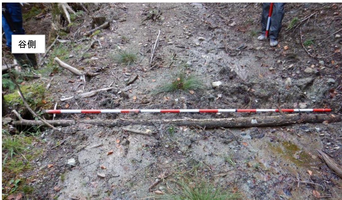
排水導線として現地に落ちていた枝条を利用
