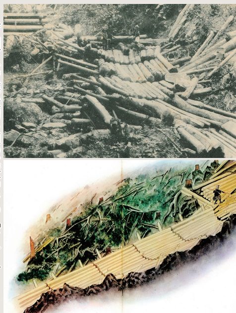
(上写真) 大正時代頃、現在の岐阜県高山市上宝町で撮影された「シユラ」
