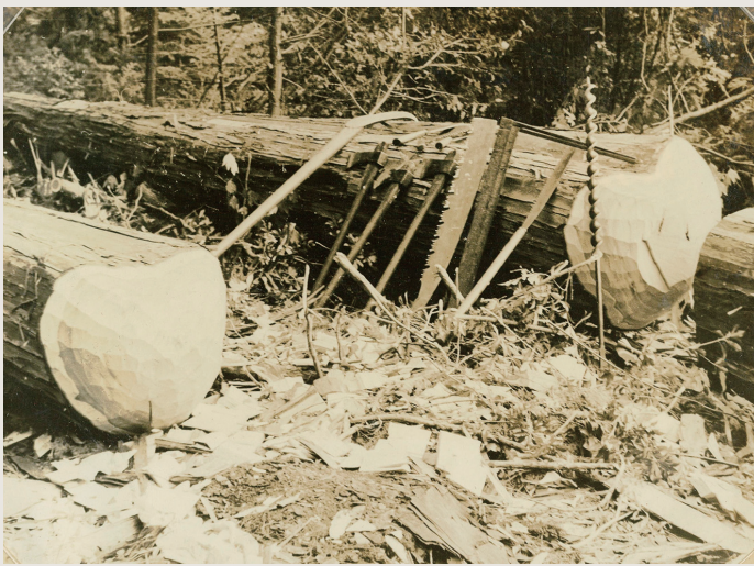
昭和20年代頃、現在の東濃森林管理署付知裏木曾国有林での造材の様子
