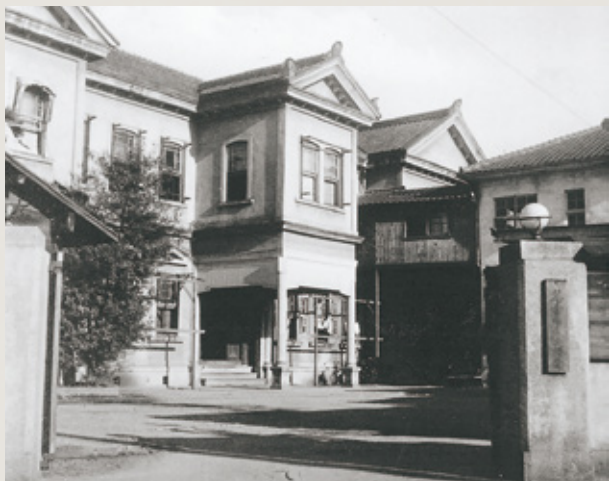
明治31年からの建物を利用していた初代の名古屋営林局庁舎(昭和20年代の写真)
