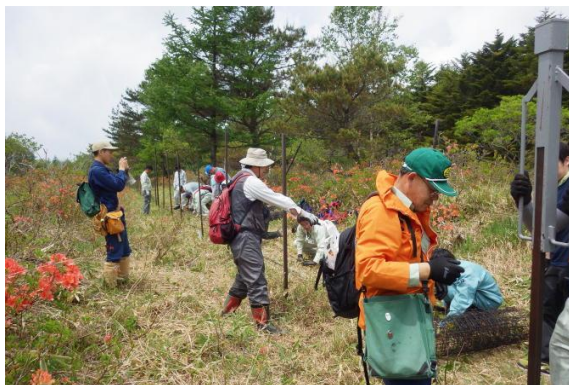
【霧ヶ峰 八島ヶ原湿原防鹿柵修繕作業】
