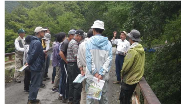
治山工事現場の見学
