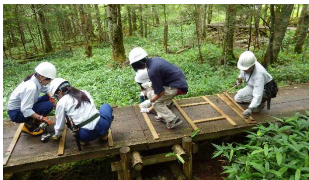
木道への滑り止めの設置
