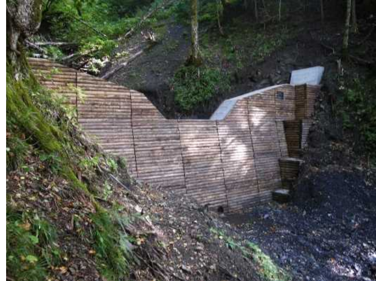
間伐材を利用した治山ダム
