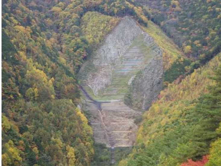
溪間工と山腹工
