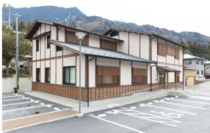
平成31年1月に竣工した新庁舎
