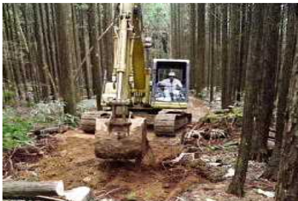
作業路網作設
