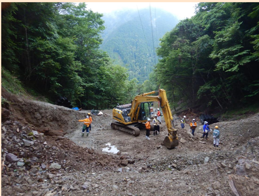
現在事業実行中の現場でチェック
