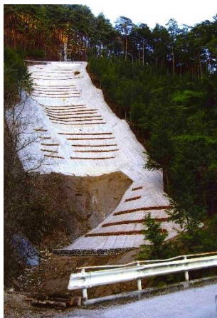
崩壊地の山腹工完成（平成 20 年）
