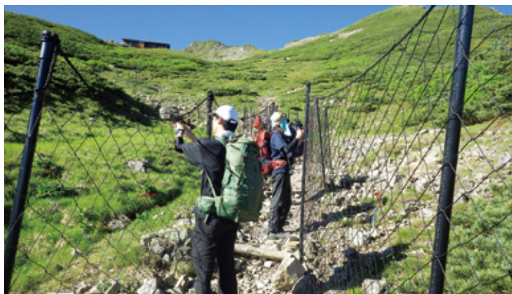
ボランティアによる防鹿柵の設置
