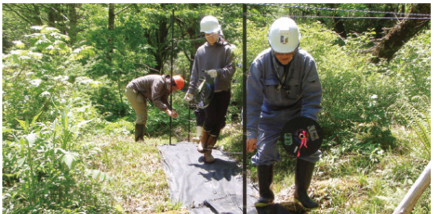
山中峠付近の湿原における電気柵設置作業
