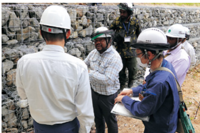
林道工事の検査業務について質問する研修生
