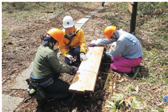
園内のベンチの補修
