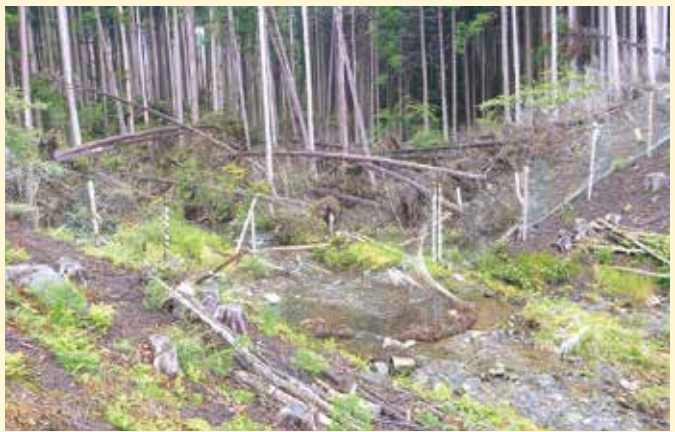
豪雨時、受け流す柵のみが損壊する様子
