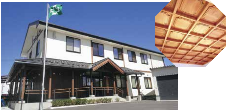
旧庁舎の古材を天井などに活用している伊那谷総合治山事業所の現庁舎
