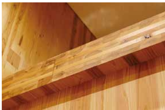
CLT【Cross Laminated Timber】 (ひき板(ラミナ)を並べた後、木の繊維方向が直交するように積層接着した木質系材料)
