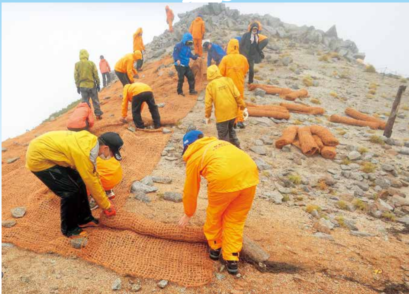
標高約2,900mでの植生マットの敷設作業
