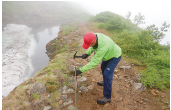
グリーンロープの設置作業
