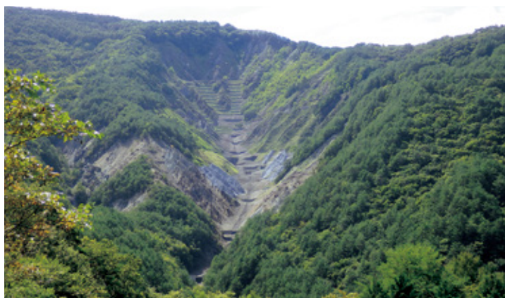
復旧が進む鳶ヶ巣大崩壊地
