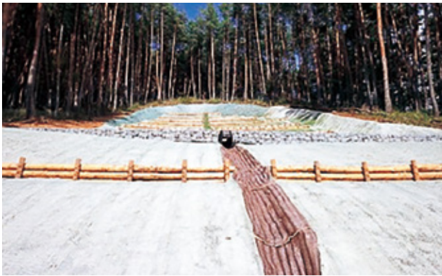
中部森林管理局長賞 長野県佐久地域振興局 山腹工（丸太積工、丸太筋工）
