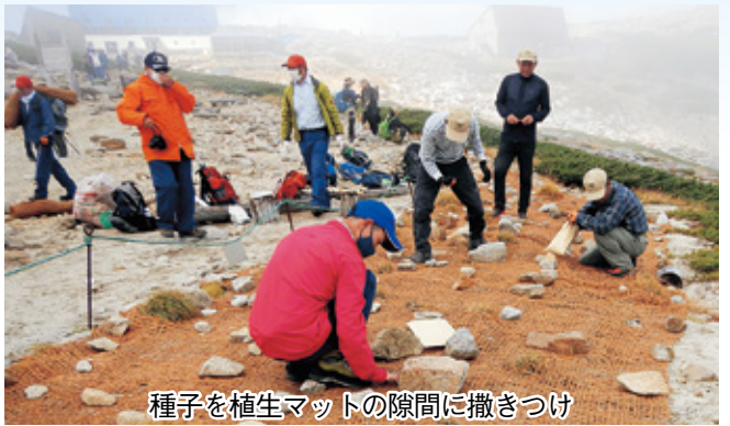
植生マットを表土の上に敷いて、固定する作業
