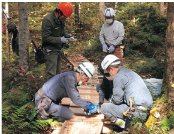
歩道修理作業の様子
