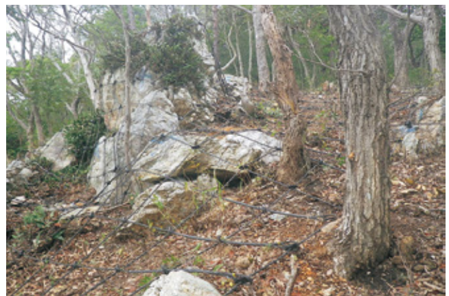
ロープネット工
