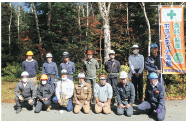
歩道修理作業に参加されたボランティアの皆様
