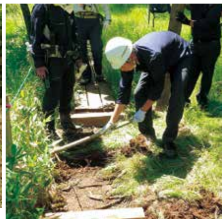
木道の改修を行っている様子
