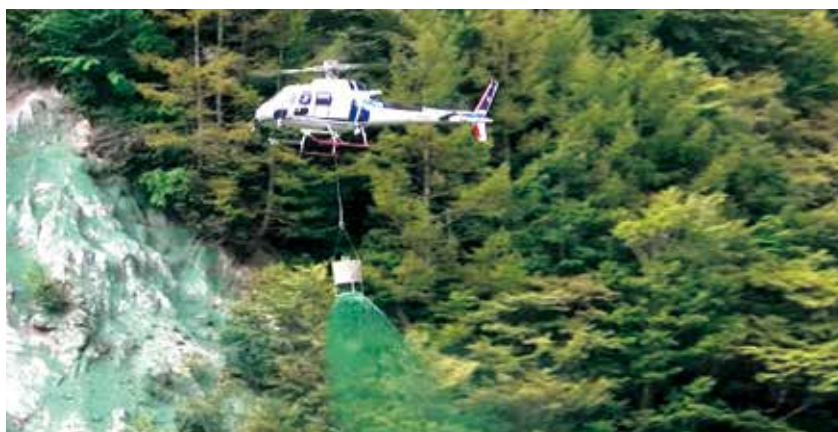
ヘリコプターによる航空実播工の様子
